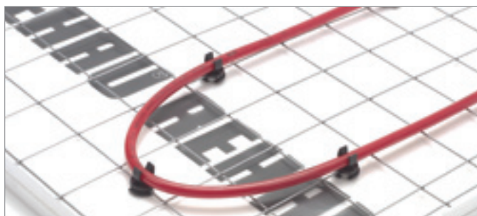
Крепление труб на арматурной сетке
