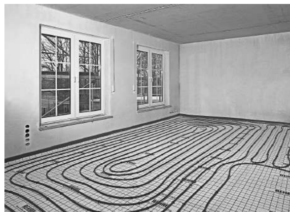
Рис. 145 Система крепления труб с помощью гарпун-скоб
