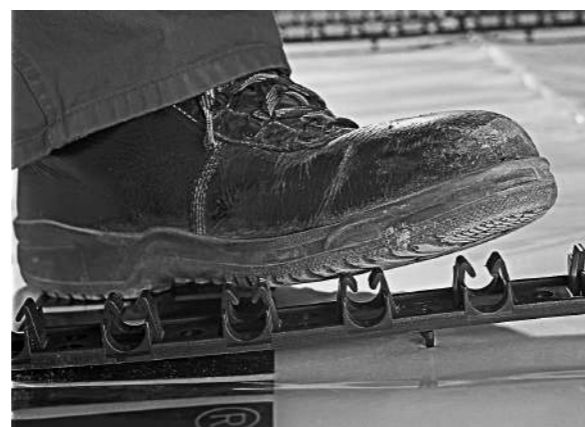
Рис. 158 Вдавливание фиксирующих шин RAUFIX в конструкцию пола
