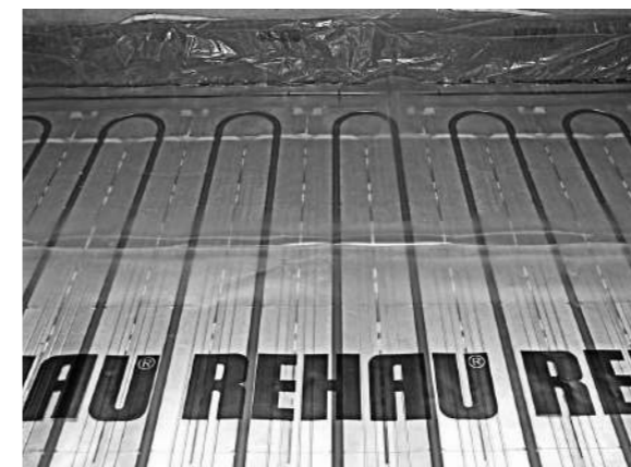
Рис. 186 Система укладки труб на теплоизоляционных матах TS-14
