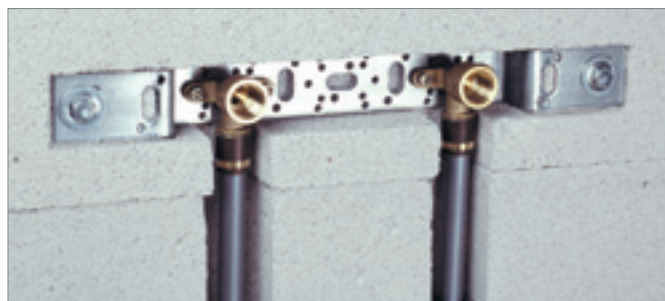
Пример монтажа настенных угольников для подключения запорной арматуры
