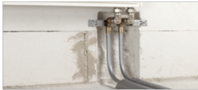
Готовый монтажный блок для подключения отопительного прибора
