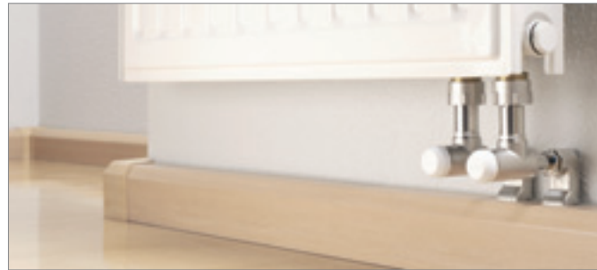
Система плинтусной разводки с SL-крестовиной RAUTITAN
