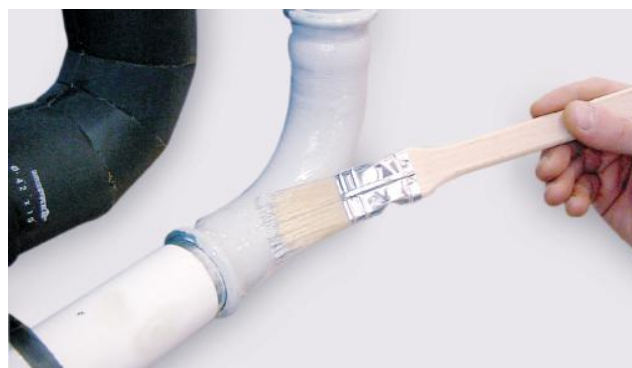
Рис. 37. Покраска соединений и труб праймером.
