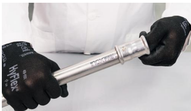
Рис. 31. Вставка трубы в пресс-фитинг.
