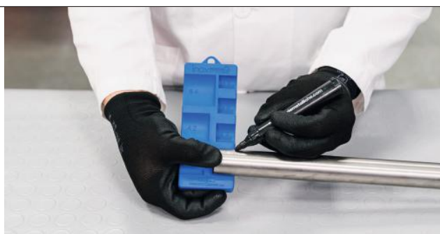
Рис. 28. Маркировка глубины вставки.
