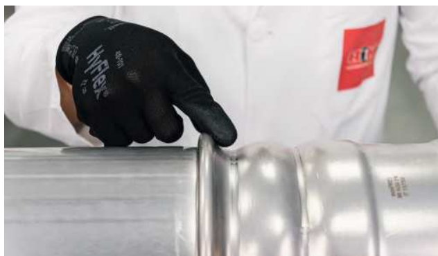
Рис. 36. Визуальный осмотр места прессования Oversize.
