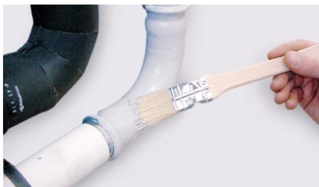
Рис. 37. Покраска соединений и труб праймером.
